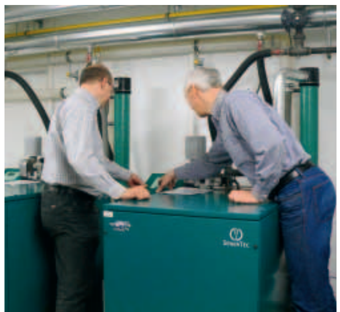
Kontrolle der Blockheiz-Kraftwerk-Module
